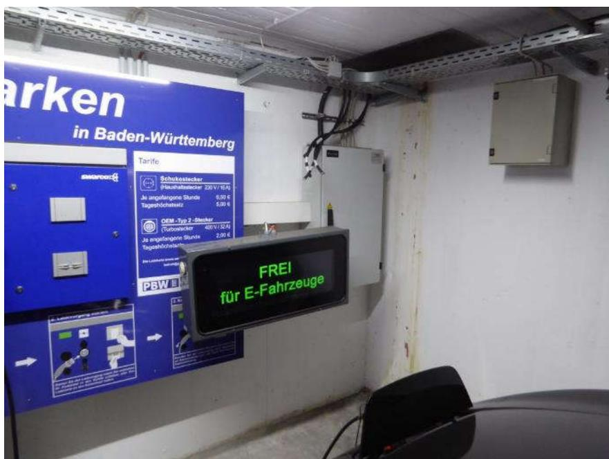
**Abbildung 6: alter Unterverteiler für die Ladesäulen - Einbausituation**
