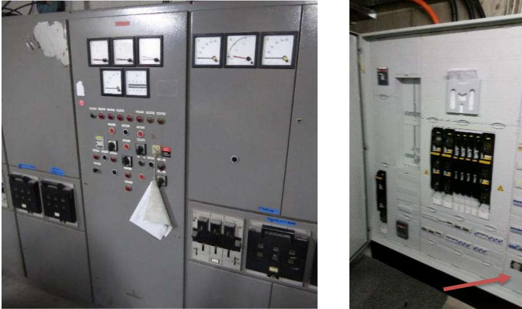
**Abbildung 3: alter Hauptverteiler links und neuer Hauptverteiler rechts**
