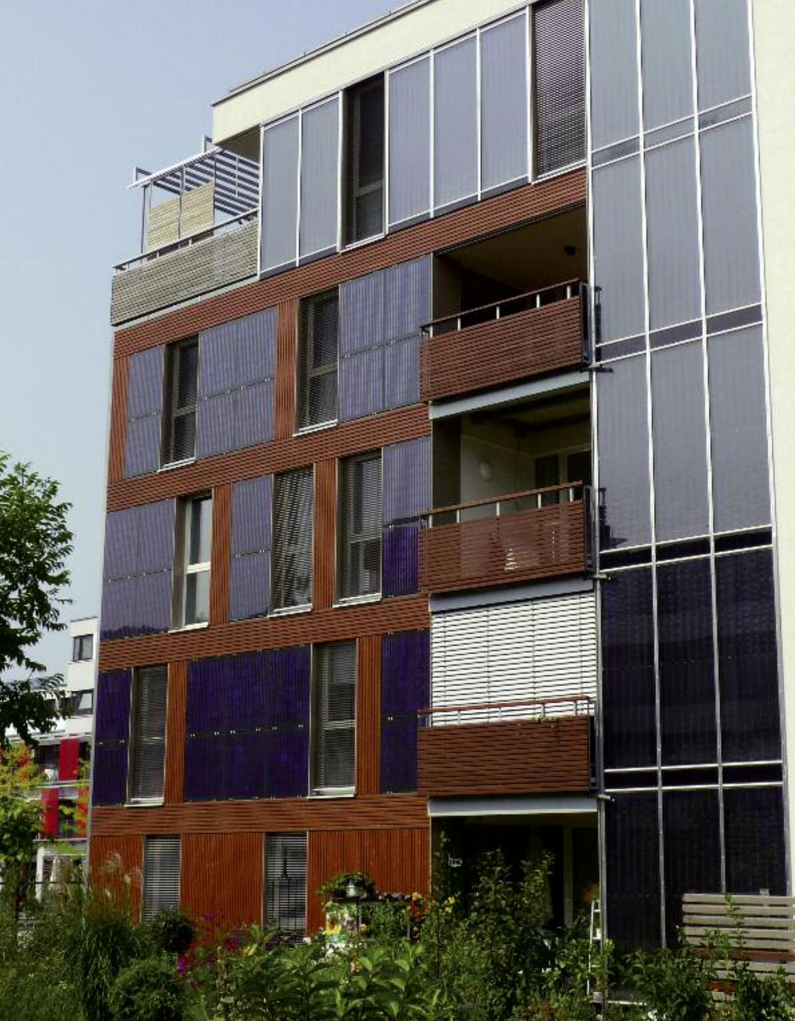
Gelungene Fassadenintegration von Photovoltaik und solarthermischen Kollektoren
