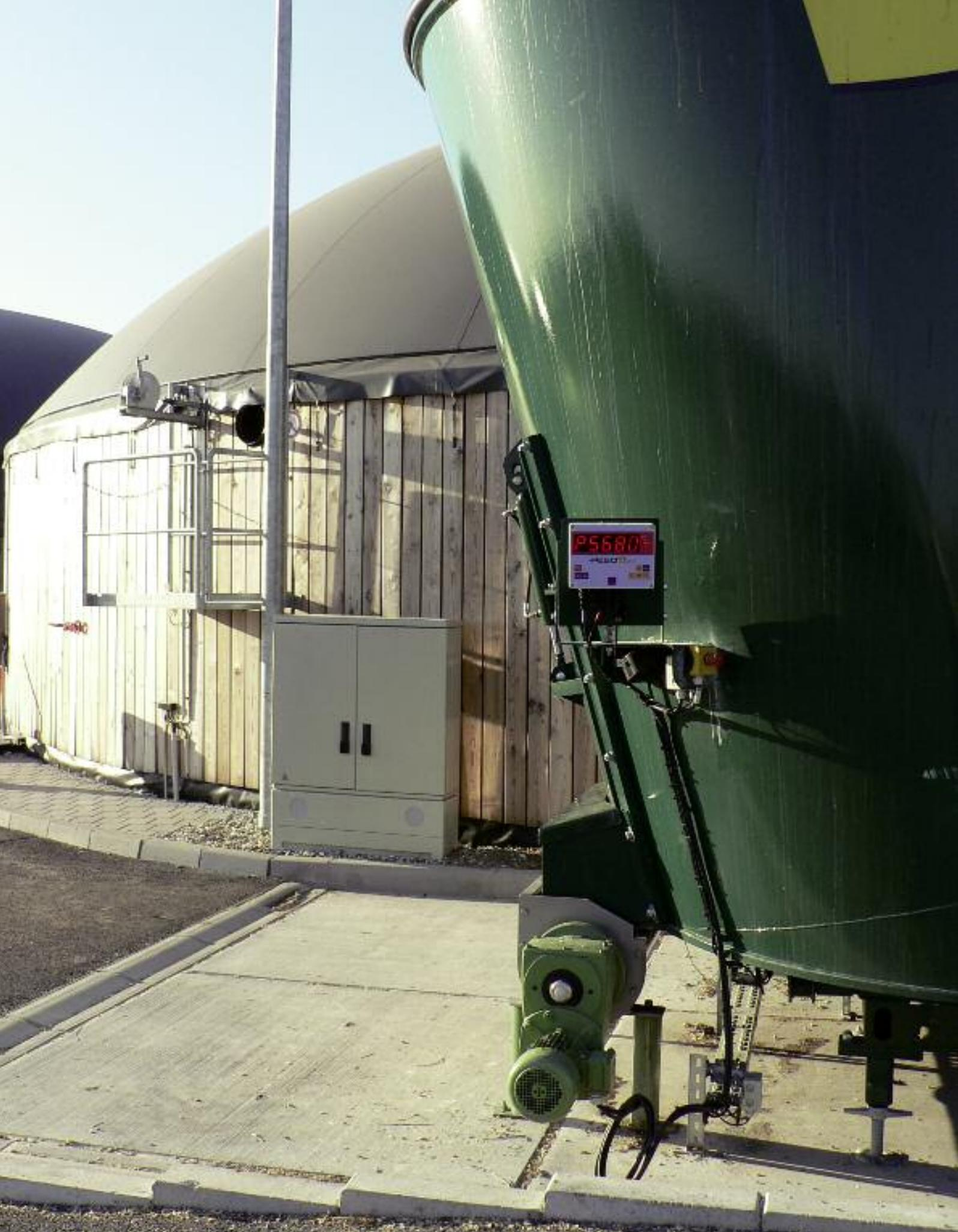
Biogasanlage mit Fermenter und automatischer Substratzuführung
