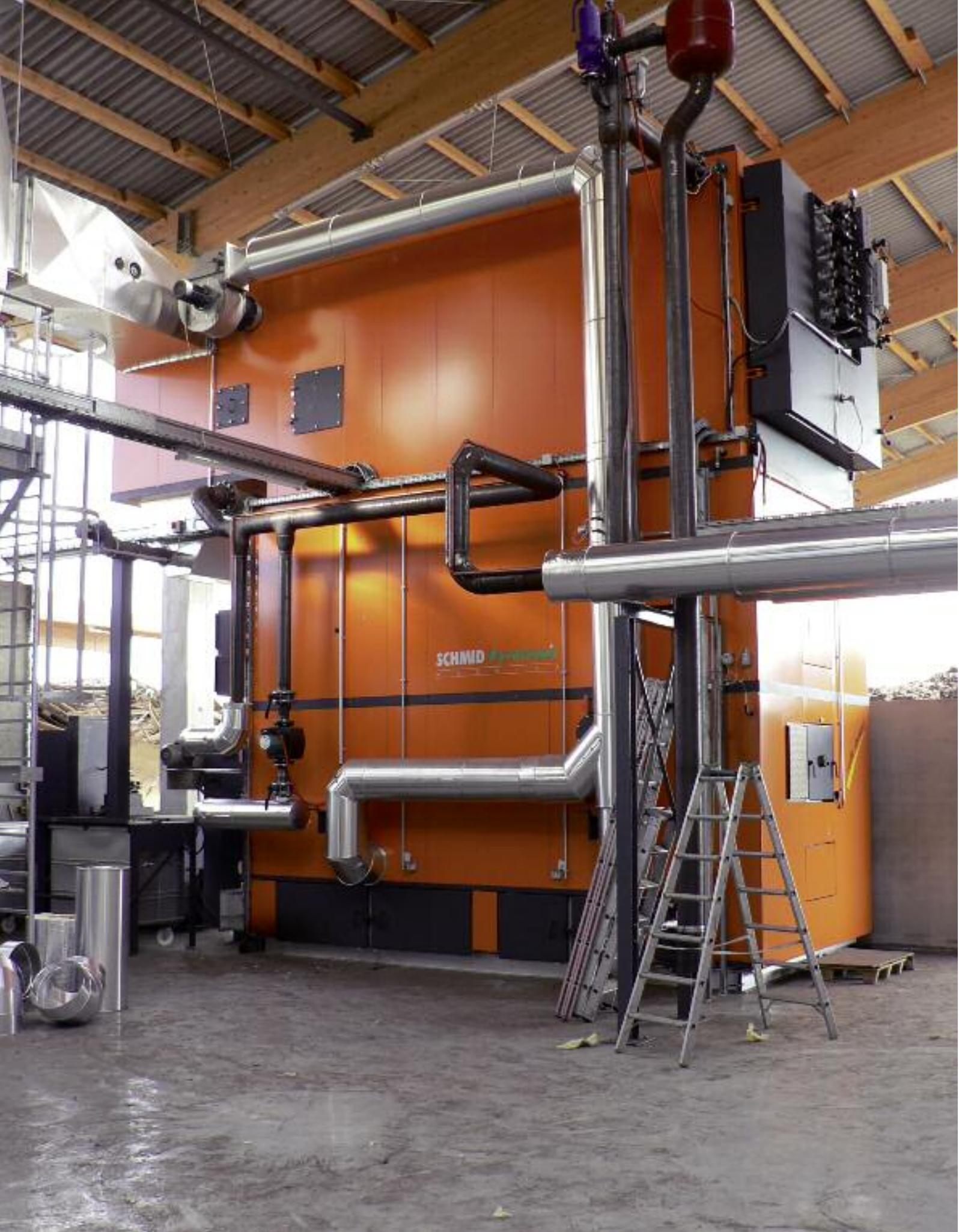
Kessel einer Holzhackschneitzelfeuerung
