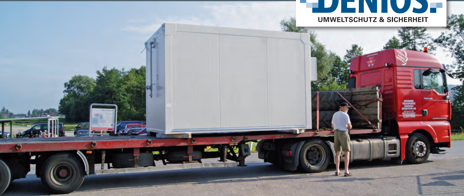
Anlieferung des Technik- / Sicherheitsraumes
