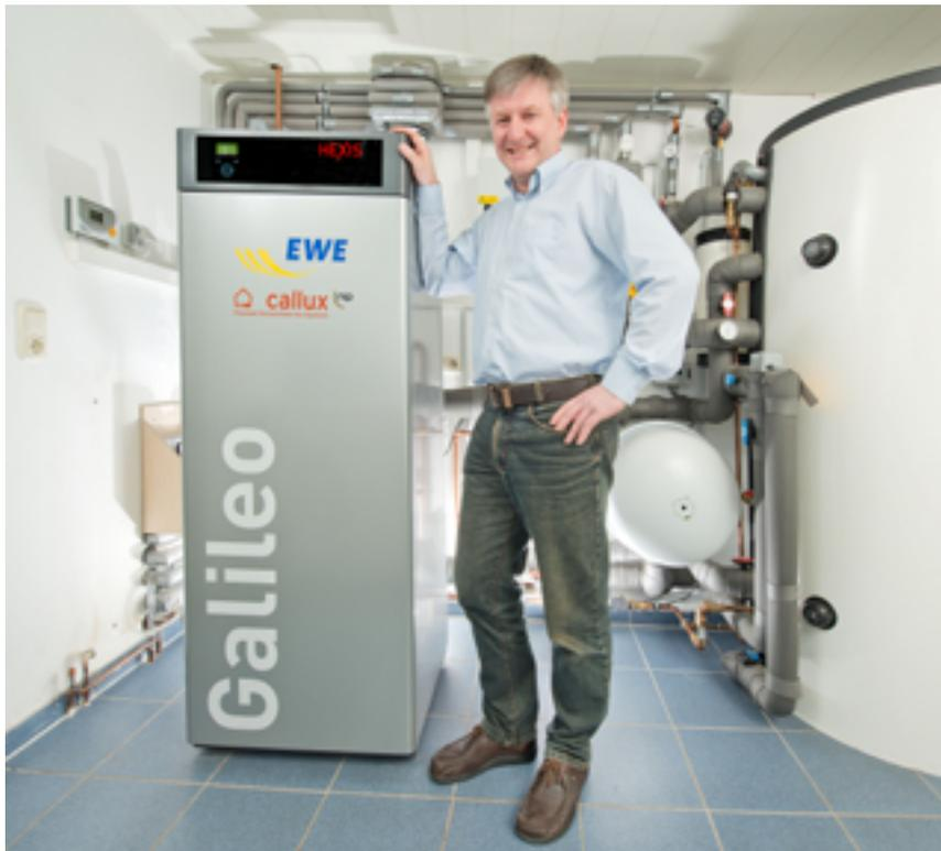
Brennstoffzellen-Heizgeräten wurde im Praxistest eine sehr hohe Verfügbarkeit nachgewiesen. Die Anlagen sind so zuverlässig wie andere Heizgeräte. Bild: EWE/HEXIS
