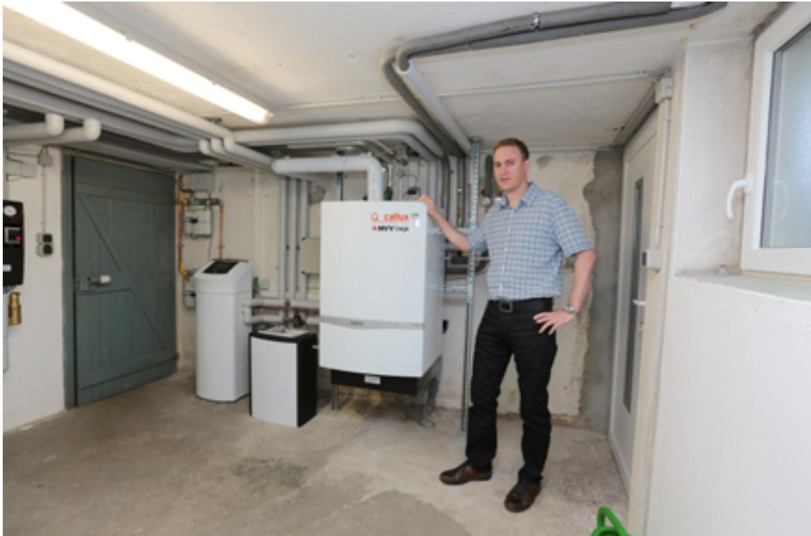
Die Systemintegration von Brennstoffzellen-Heizgeräten in bestehende Heizsysteme ist in der Praxis gelungen, was besonders für den Modernisierungsmarkt relevant ist.
