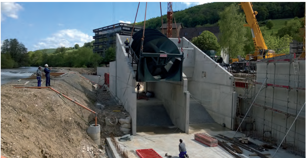
Einbau einer Wasserkraftschnecke in Künzelsau
