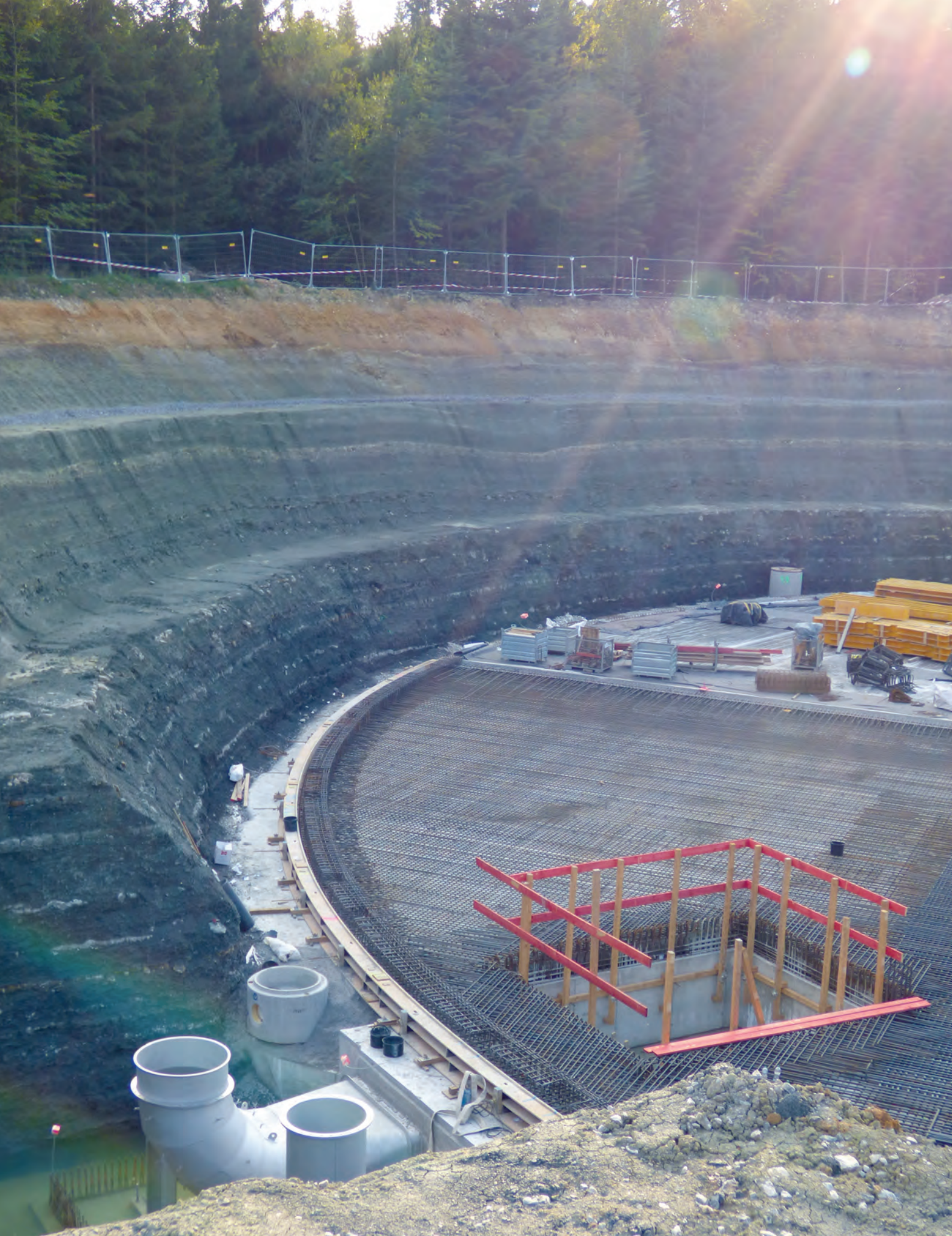
Bau eines Wasserspeichers für Windstrom bei Gaildorf
