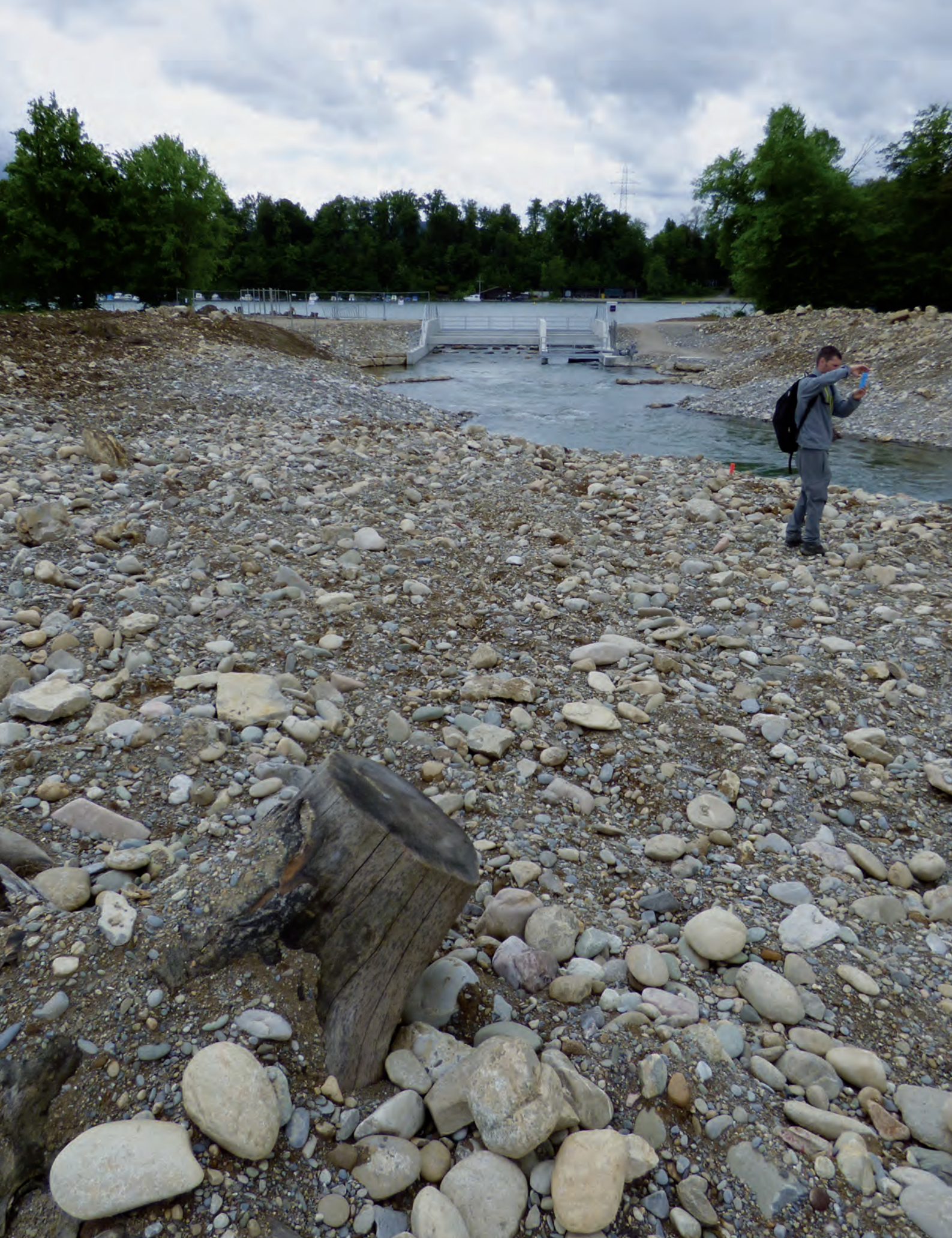
Neu angelegtes Umgehungsgewässer beim Wasserkraftwerk Ryburg-Schwörstadt
