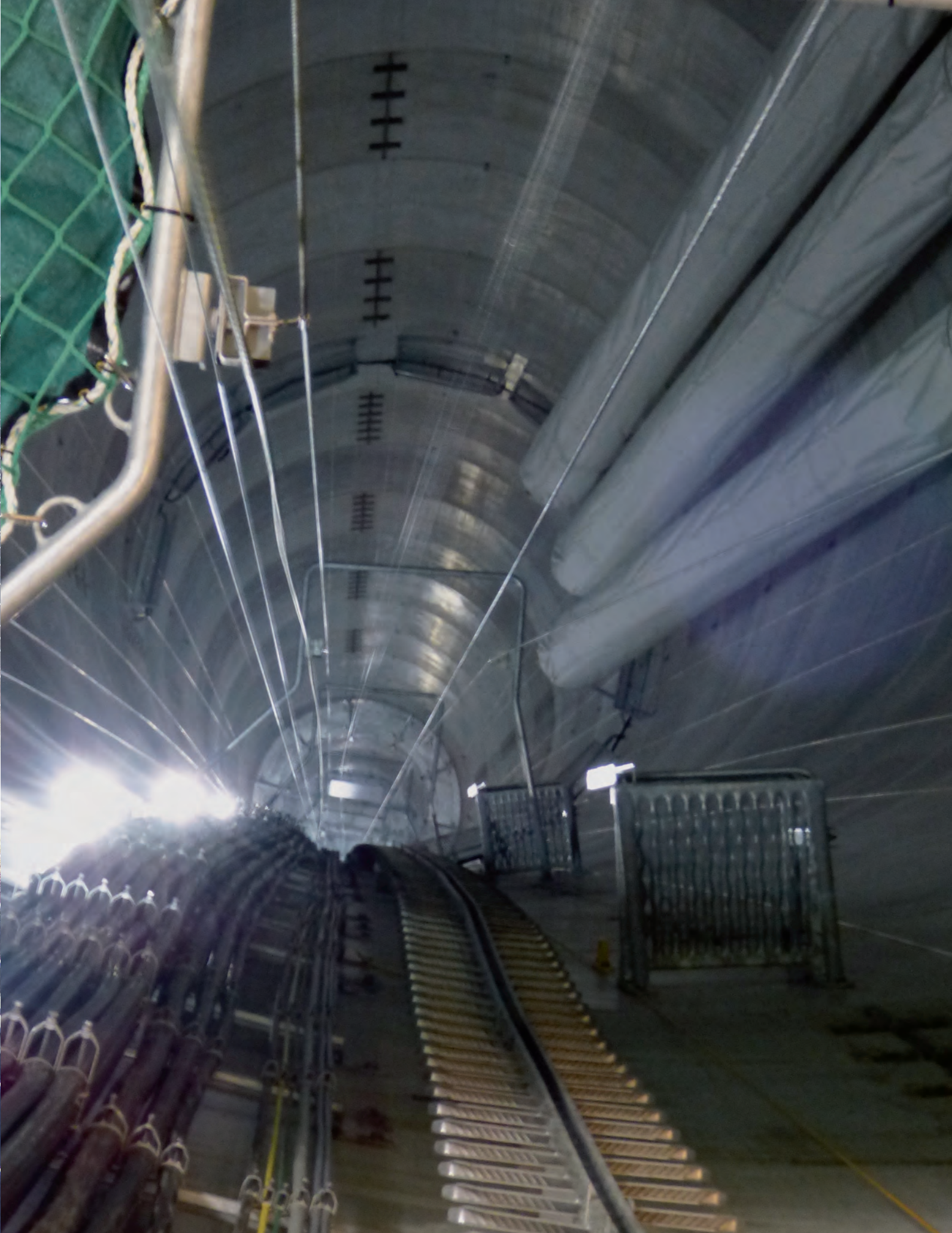
Ansicht in den Turmschaft einer modernen Windkraftanlage
