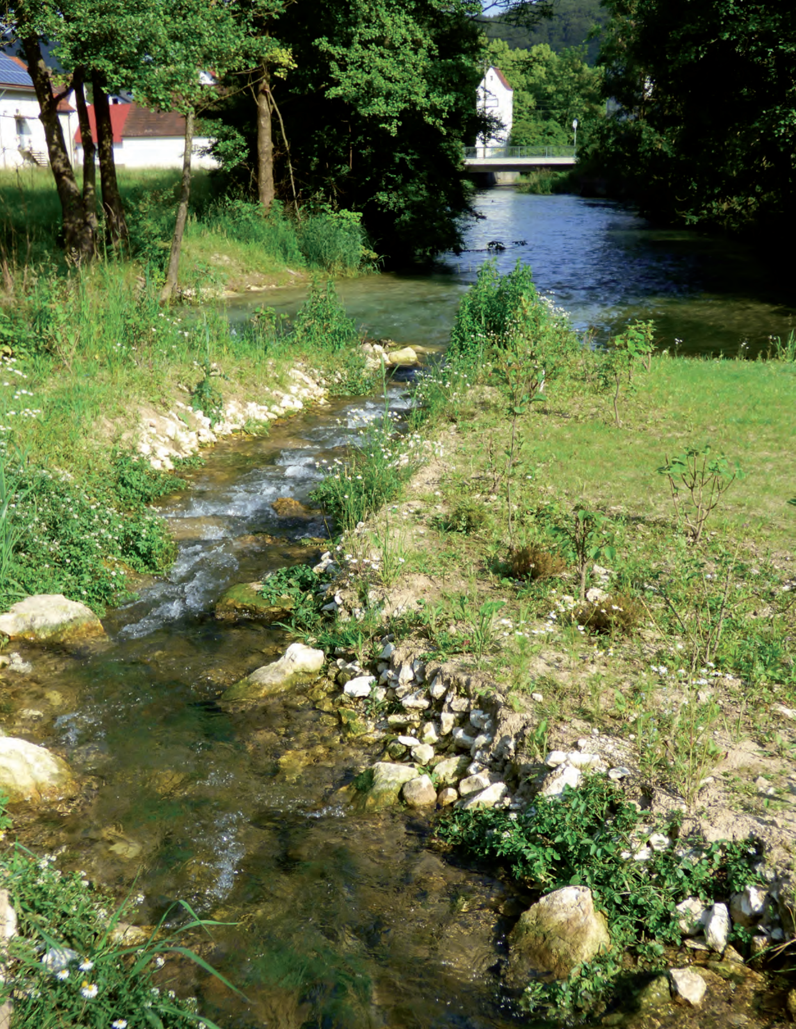
Fischaufstieg einer kleinen Wasserkraftanlage an der oberen Blau
