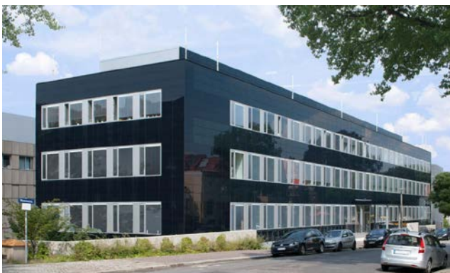
Gebäudeintegrierte CIGS-Dünnschichtphotovoltaik mit 500 Quadratmetern Modulfläche. Foto: Manz AG
