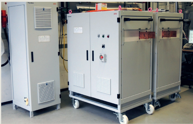
// Doppelgleichrichter für Elektrolyse-Blöcke bis 0,6 m 2 Elektrodenfläche bei 0,8 A pro cm 2
