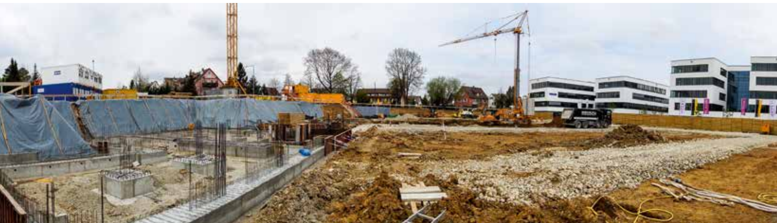
// Stand der Gründungsarbeiten am 17. April 2015. // Progress of the foundation work on 17 April 2015.
