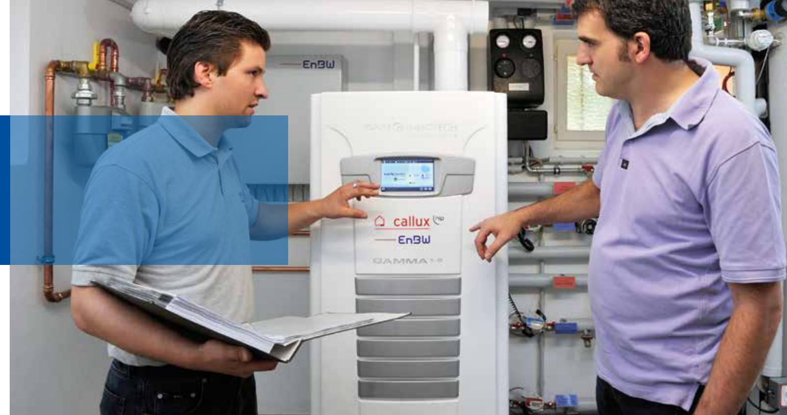
// Fast 500 Brennstoffzellen-Heizgeräte wurden im Rahmen von Callux installiert und getestet. // Almost 500 fuel cell heaters were installed and tested as part of Callux.
