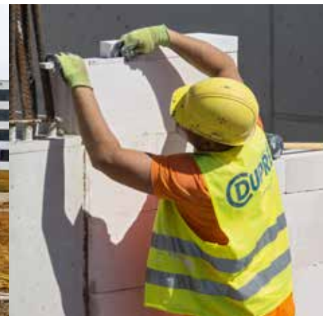
// Maurerarbeiten Ende Juni 2015. // Masonry work at the end of June 2015.
