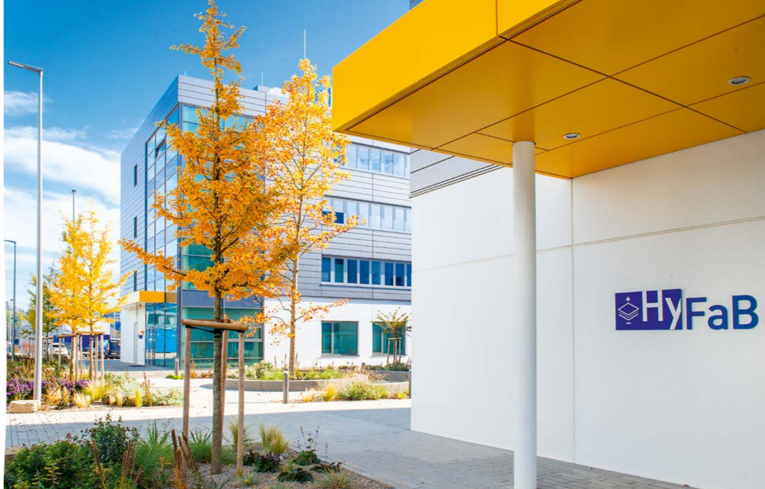
^ Das neue Brennstoffzellen-Testzentrum in HyFaB.
