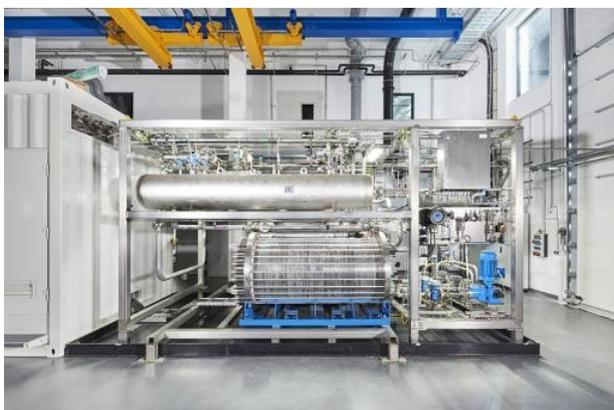
Erprobung eines Elektrolysestacks im 0,5 Megawatt Maßstab.
